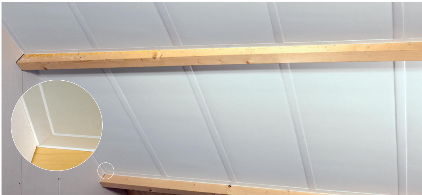
Hoekoplossing met in verstek gezaagde profielen.
