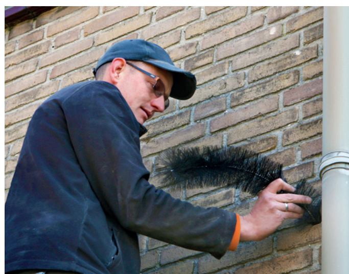
Plaatsen van borstels in de spouw op de erfgrans naar de burens.
